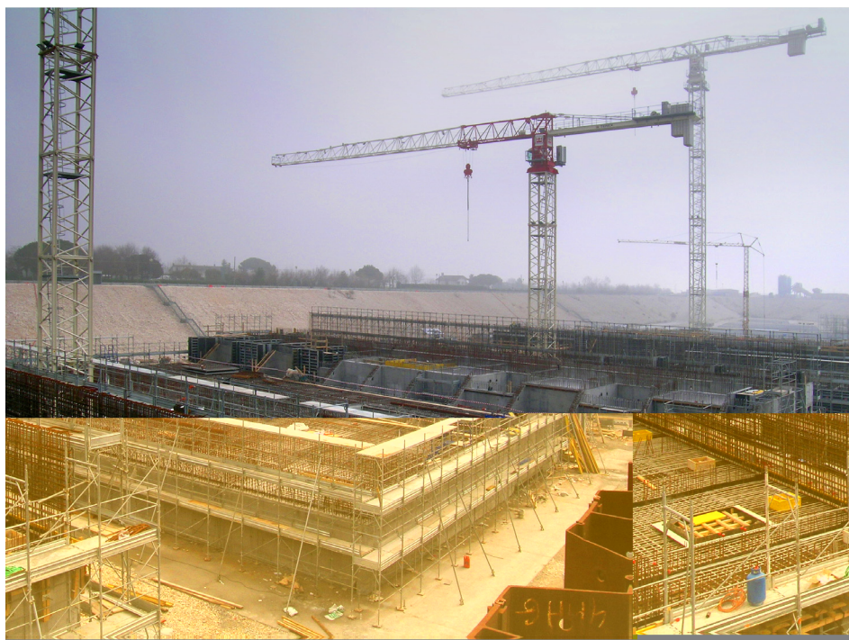
Cantiere di prefabbricazione delle barriere mobili a Punta Sabbioni. L'utilizzo come spazio di cantiere di un bacino del futuro porto rifugio ha permesso di evitare l'occupazione di circa 7 ettari di terreno.
